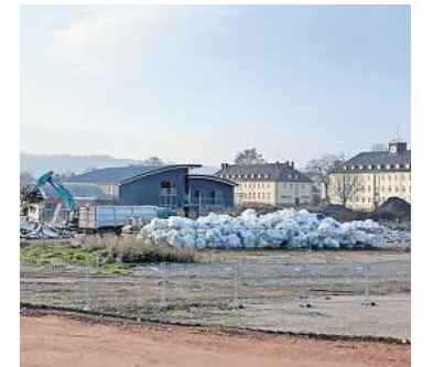
Die Abrissarbeiten auf dem Gelände der alten Linsingen-Kaserne sollen voraussichtlich Mitte Dezember abgeschlossen sein.
